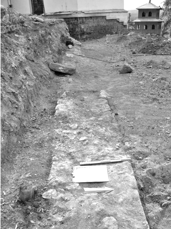
Іл. 4 Залишки муру оборонної стіни монастиря у західній частині розкопу
