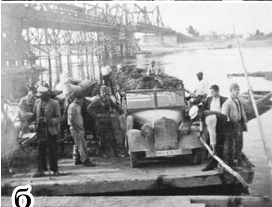
Ил.5. Переправа (пором) через р. Дністер: а) вид з північного сходу, 1942 р. б) вид з південного сходу, 1942 – 1943 рр.
