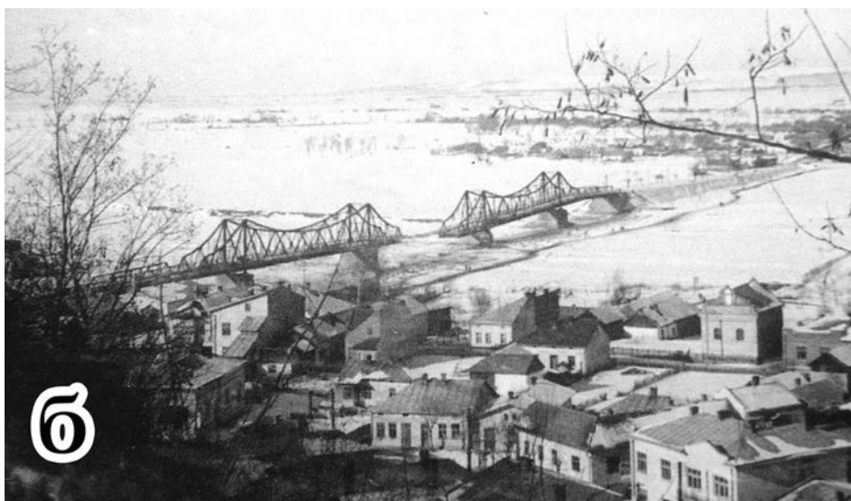
Іл. 3. Зруйнований Металевий міст в Галичі: б) вид з Замкової гори, зима 1942 р.
