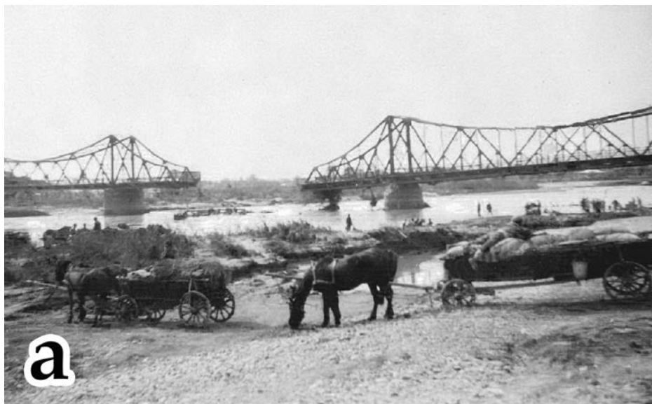
Іл. 3. Зруйнований Металевий міст в Галичі: а) вид з північного сходу, 1941 р.
