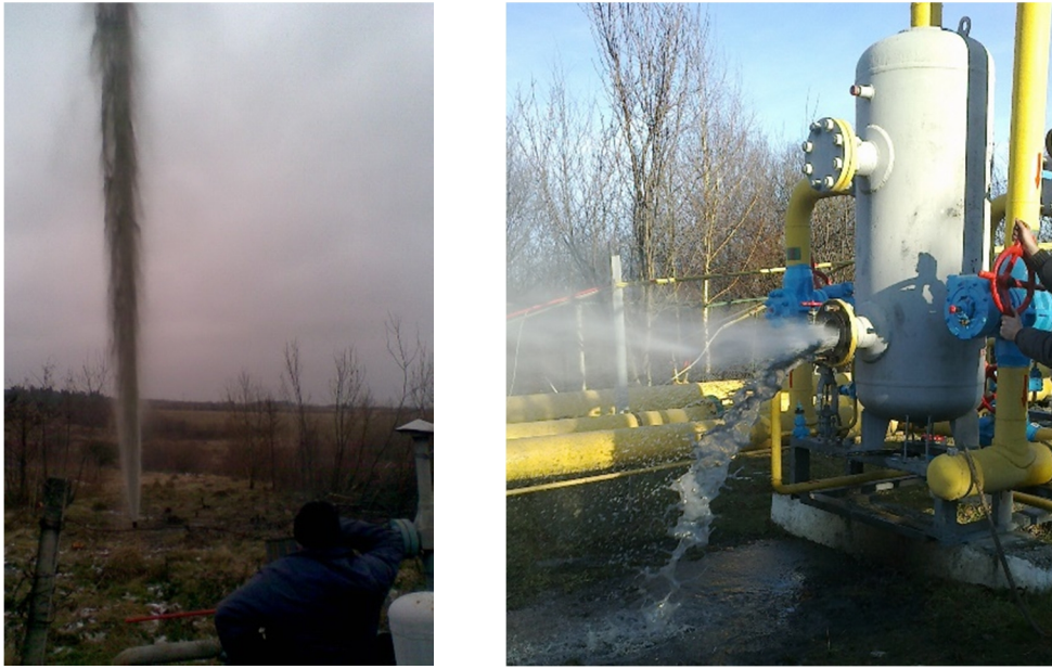
Рис. 2. Аварійний випуск газу і рідини в атмосферу з порожнини газопроводу з причини утворення великих рідинних скупчень.
